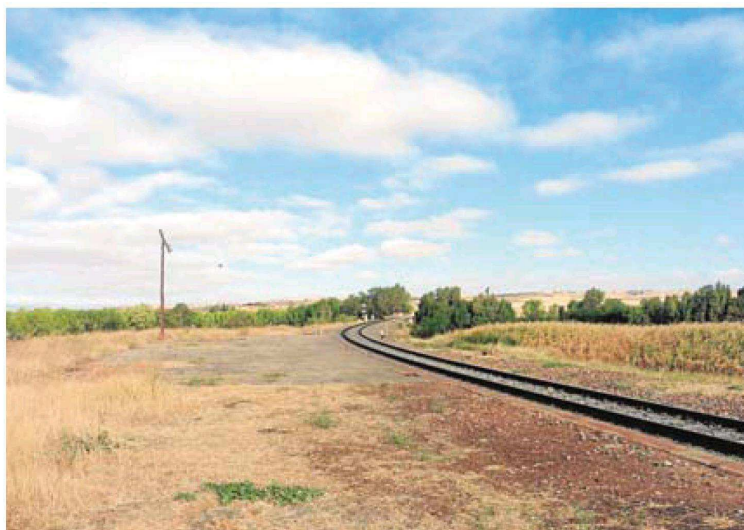
El antiguo apeadero. :: P. E.
