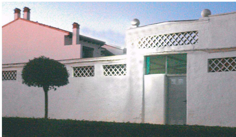
Aspecto de la fachada actual del matadero. ■ ■ P. E.
