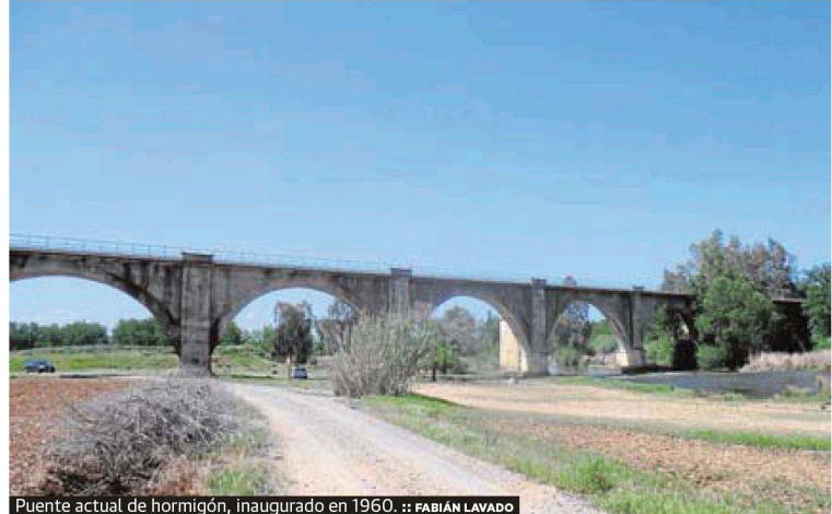
Puente actual de hormigón, inaugurado en 1960. :: FABIAN LAVADO
